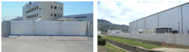
例)浸水被害を踏まえ浸水対策を実施している事例 (株)佐賀鉄工所HPより
