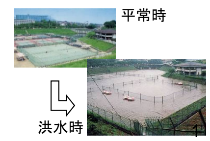
貯留施設の整備
