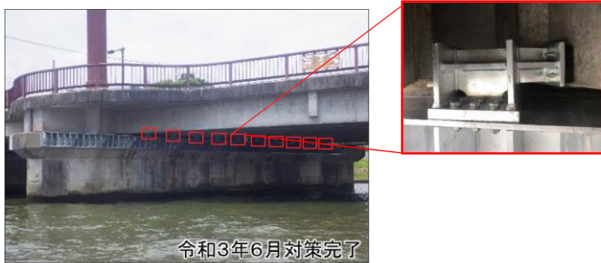
吾妻橋（石川県珠洲市）の耐震対策
