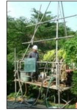
【ボーリング調査】
