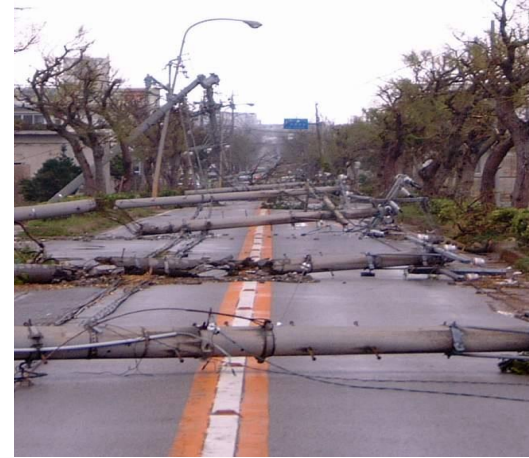
電柱の倒壊による道路閉塞
