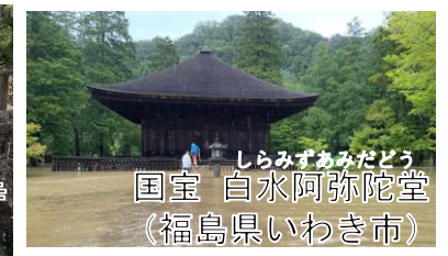
【被災例】台風第13号で床上20cmまで浸水 土砂撤去や被害を受けた部材の早急な復旧、及び設備の嵩上げ等の対策を行う
