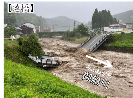
未対策箇所での被災事例 （国道445号熊本県山都町令和5年7月の大雨による橋梁流出）
