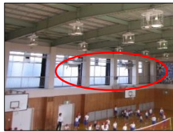
体育館への空調設置
