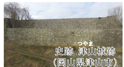
【対策例】排水対策を含む二の丸東側石垣の老朽化対策を実施
