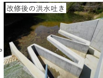
改修後の洪水吐き 洪水吐きの流下能力を12.5m³/sから45.5m³/sに3倍以上増強
