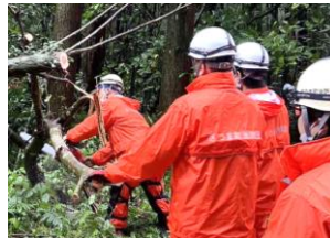
配備したチェーンソー等を使用した倒木の撤去作業
