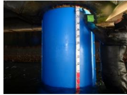
鋼管杭の被覆防食の更新
