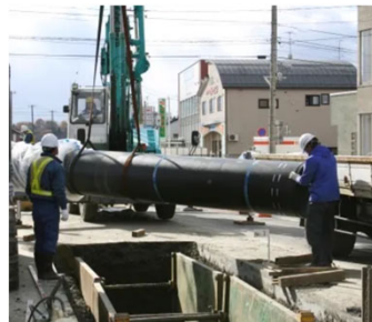
耐震管の布設工事
