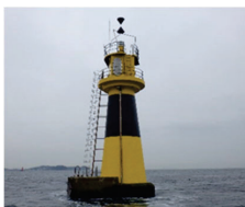
①角石灯標 (工期短縮の取組事例) 事前に陸上で資材の組立を行い現場の工期短縮
