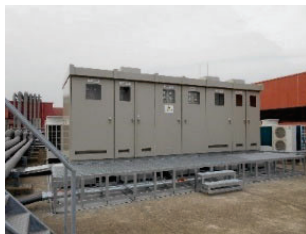
対策後(屋上階)
