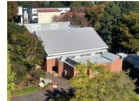
体育館(屋根塗装完成後)
