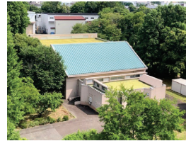
体育館(屋根塗装着手前)
