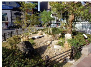
雨水貯留浸透能力を有する雨庭
