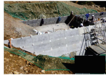
残存型枠を用いた砂防堰堤施工
