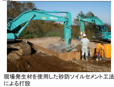
現場発生材を使用した砂防ソイルセメント工法による打設
