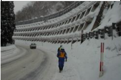
人による現地確認の様子
