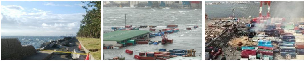
越波による護岸の倒壊 浸水による蔵置コンテナの流出 浸水によるコンテナ火災
