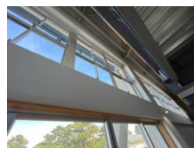
内壁、外部建具の改修状況
