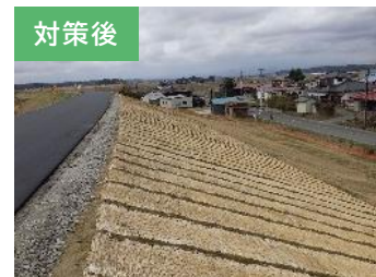
堤防法面の補修
