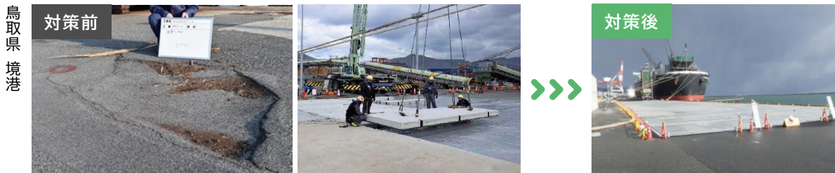
施設の老朽化により陥没等が発生していた岸壁に対し舗装工事を実施
