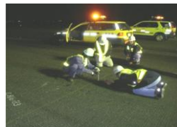
点検等による劣化・ 損傷程度の確認
