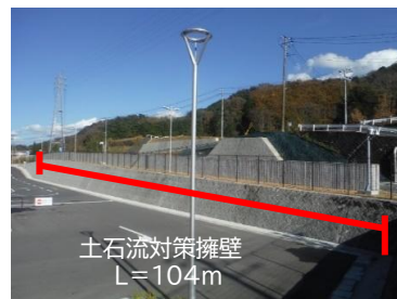
土石流対策擁壁の設置
