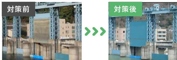
ゲート塗装(耐久性の高い塗料を使用) 劣化状況を評価の上、更新
