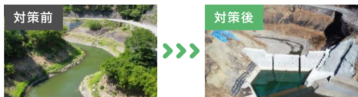
貯砂ダムの設置
