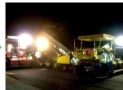
老朽化した滑走路舗装の改良
