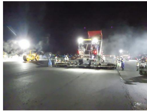
滑走路舗装の舗設
