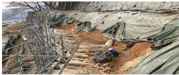
石垣整備：一旦解体し栗石や裏込石を詰め直す作業
