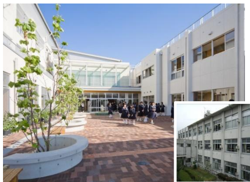
長寿命化改修により建て替え同等の教育環境を確保
