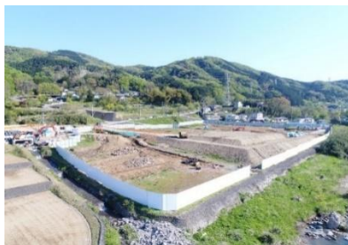
敷地地盤の高上げ(浸水対策)
