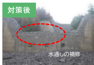
1号堰堤 水通しの補修
