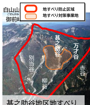
甚之助谷地区地すべり
