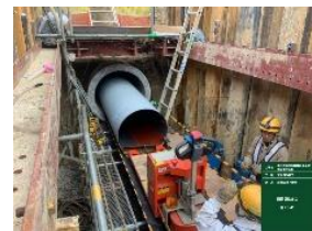
既設管の中に耐震性のある鋼管を挿入する工法(PIP工法)の実施
