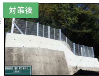
急傾斜地崩壊防止施設 既存施設の改築により、地域における安全性を向上
