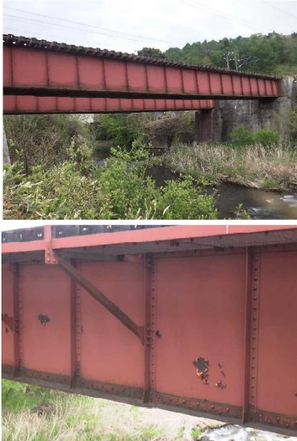
橋梁の老朽化が進行
