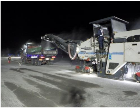
老朽化した滑走路舗装の撤去
