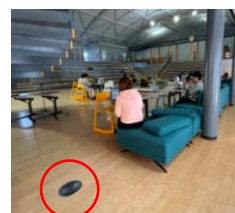
床下空調設備
