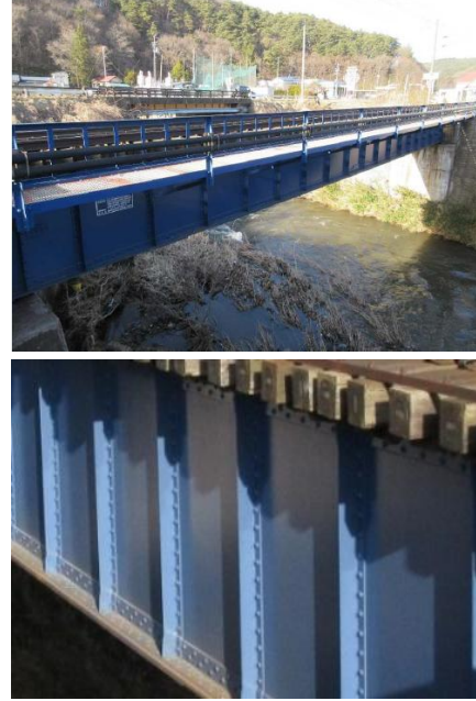
高耐久性・重防食塗料の塗装により長寿命化や維持管理コストの低減が期待される
