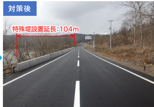
道路沿いに特殊堤を設置
