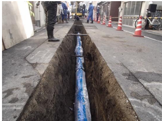
耐震管の布設イメージ
