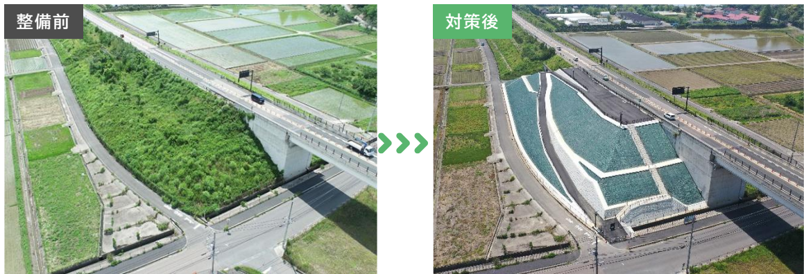
道路の高架区間等を洪水時の緊急避難場所として活用するため、避難施設の整備を実施
