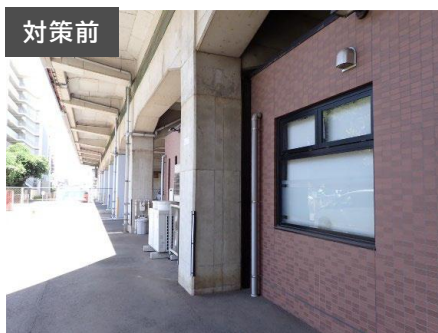
橋脚の一面せん断補強
