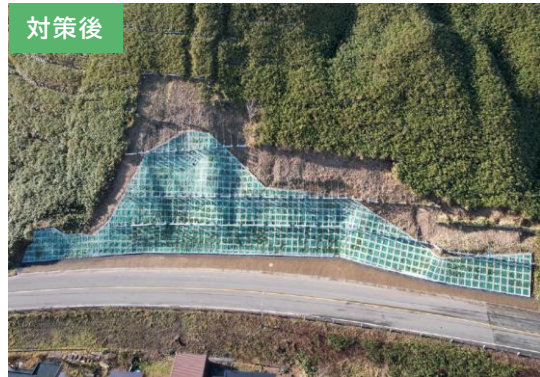
同区間において法面対策を実施
