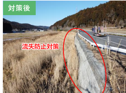
道路流出対策を実施
