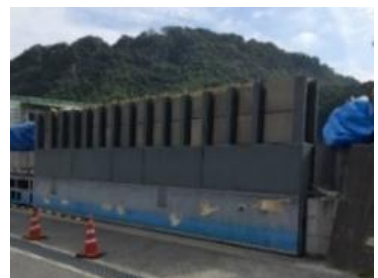
施設のかさ上げ(浸水対策)
