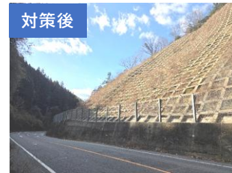
法面对策(吹付砕工事)
