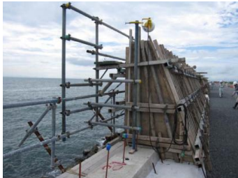
既存護岸の嵩上げ
