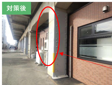
橋脚の耐震性が向上し、地震による損壊を防止
