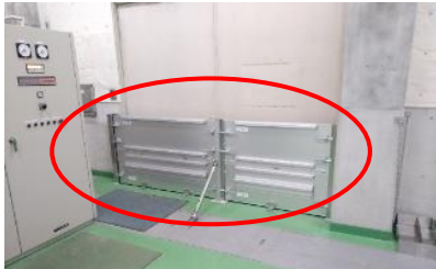
止水板の設置
