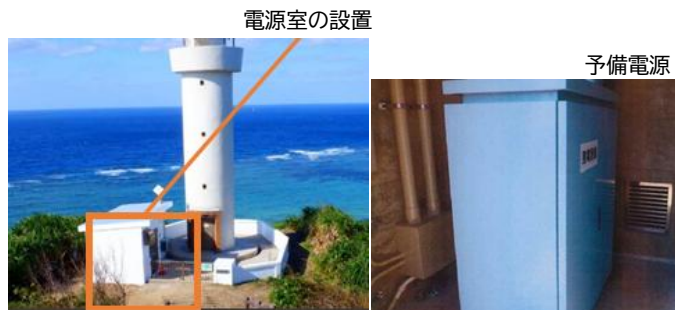
電源室の設置 予備電源の整備又は主電源の太陽電池装置化により、停電時の灯台の消灯を防止
