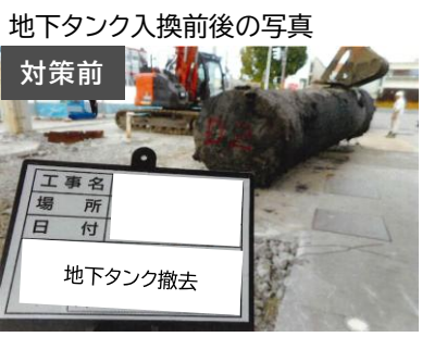
鋼製一重殻タンクの撤去及び大型二重殻タンクの設置
