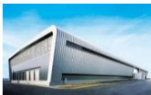
データセンター建物
