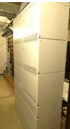
経年劣化した電話交換設備の更新
