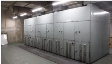
受変電設備の改修
