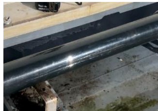
給水管改修による災害時の飲料水の確保
