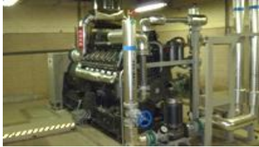
自家発電設備の改修
