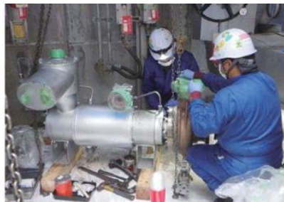
処理施設における補修作業
