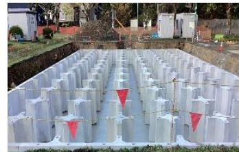
公園の地下に雨水貯留浸透施設を設置
