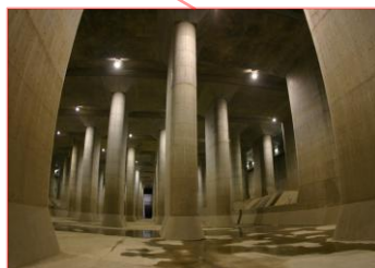
首都圏外郭放水路(調圧水槽)
