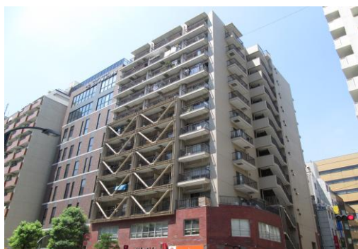
耐震改修を実施した建築物
