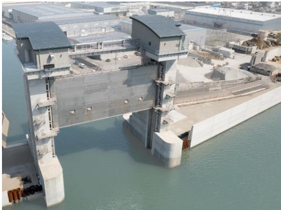
津波から市街地を防護する水門整備
