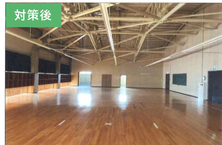
躯体にブレースを設置し耐震性能の向上を図った
