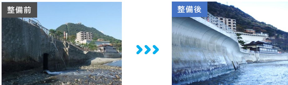
高潮等から市街地を防護するための護岸整備
