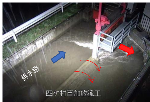
排水路に新設した余水吐へ雨水が流入している様子。 余水は幹線排水路に流入する。
