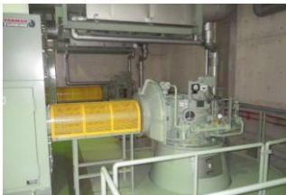
自然に排水できない雨水をポンプで揚水して公共用水域に放流する
