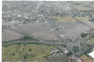
関東・東北豪雨による浸水被害状況
