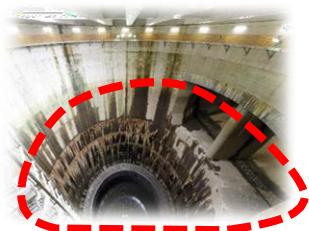
首都圏外郭放水路 第1立坑から調圧水槽への流入状況
