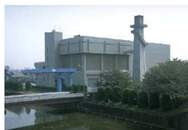
排水機場の整備
