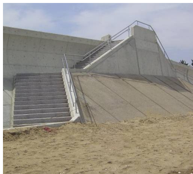
階段・スロープ等の整備
