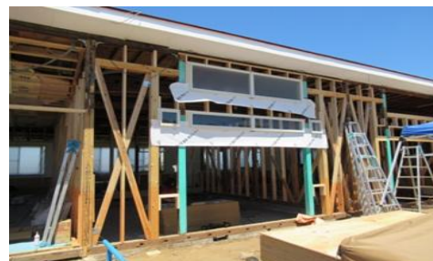
整備中の様子
