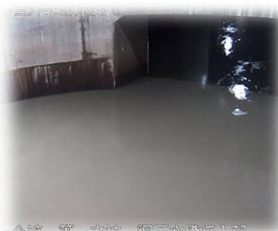
首都圏外郭放水路 第1立坑から調圧水槽への流入状況
