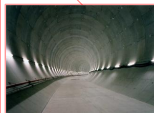
シールドトンネル
