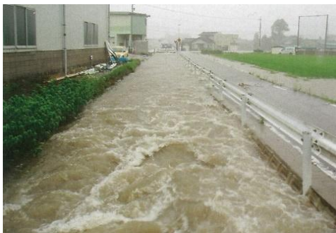
水路からの溢水により道路及び農地が冠水。
