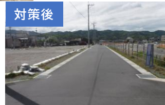
整備後の道路(幅約6m)
