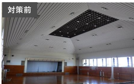
特定天井(天井仕上げ材及び下地材)の撤去、落下防止の天井設置機器(照明器具・火災報知器など)の更新工事、天井仕上撤去に伴う内装改修工事を実施
