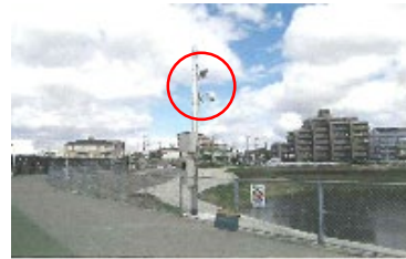
監視カメラの設置
