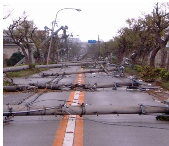
電柱の倒壊による道路閉塞
