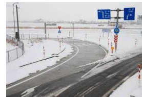
消融雪施設の整備
