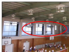
体育館への空調設置
