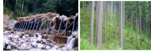
流木捕捉式治山ダムの設置
