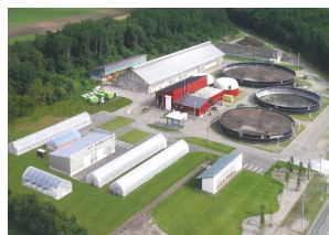
バイオガス発電・熱利用
