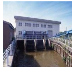
排水機場の整備
