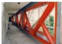
鉄骨ブレースによる壁の補強
