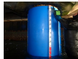
鋼管杭の被覆防食の更新
