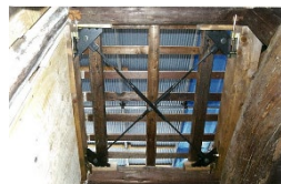
構造用合板補強（床・壁の内部）
