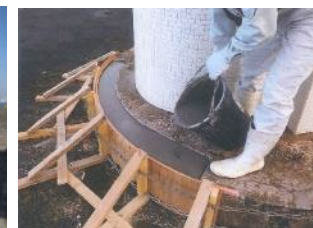
▲亀裂補修(環境遮断)
