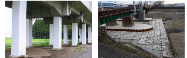
鋼板巻きによる高架橋の耐震補強 鉄道橋りょうの流失・傾斜対策
