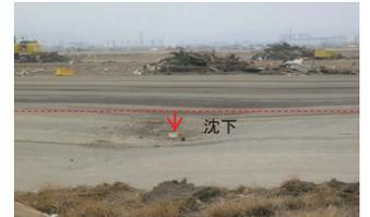
液状化による舗装沈下状況
