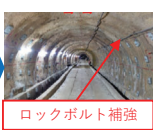
青函トンネルの老朽化対策 （先進導坑の盤ぶくれ対策）
