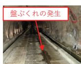
青函トンネルの老朽化対策 （先進導坑の盤ぶくれ対策）
