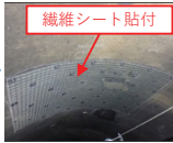
トンネルの老朽化対策 （繊維シート貼付）
