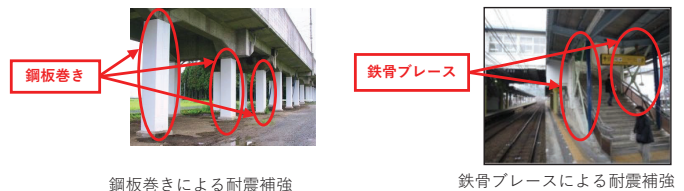
鋼板巻きによる耐震補強
