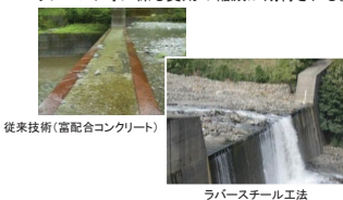
ラバーsteel工法
