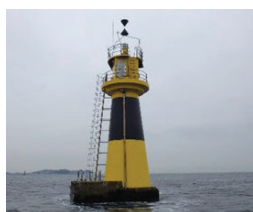
①角石灯標 (工期短縮の取組事例)
