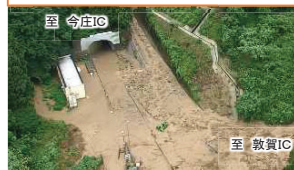
E8北陸自動車道(令和4年8月の大雨)
