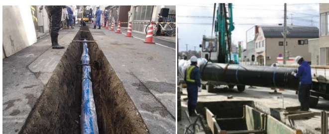
耐震管の布設イメージ
