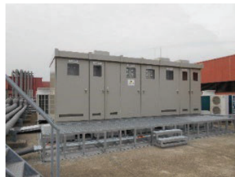
対策後(屋上階)
