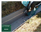
内面ライニング施工状況
