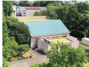
体育館(屋根塗装着手前)
