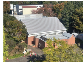
体育館(屋根塗装完成後)
