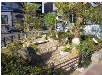
雨水貯留浸透能力を有する雨庭
