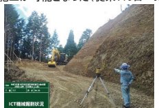
3DMGバックホウによる掘削状況
