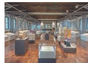
展示スペースの耐震化 (旧集成館機械工場)
