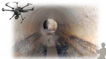
管路内部の ドローン調査のイメージ
