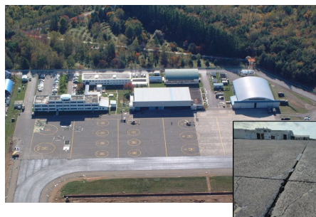
エプロンの劣化
