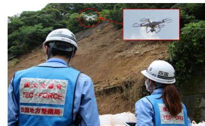
ドローンを用いた被災状況調査
