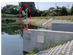
水位計等遠隔監視機器の設置
