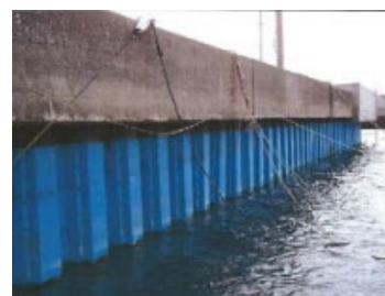
岸壁、鋼製矢板の腐食対策
