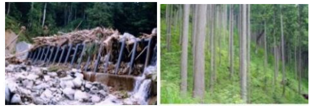
流木捕捉式治山ダムの設置 荒廃した森林の整備
