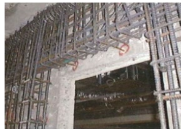
下水処理場の耐震化
