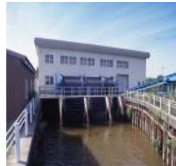
排水機場の整備
