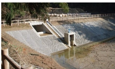
農業用ため池の整備
