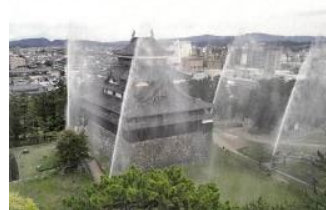
放水銃点検 (国宝 松江城天守)
