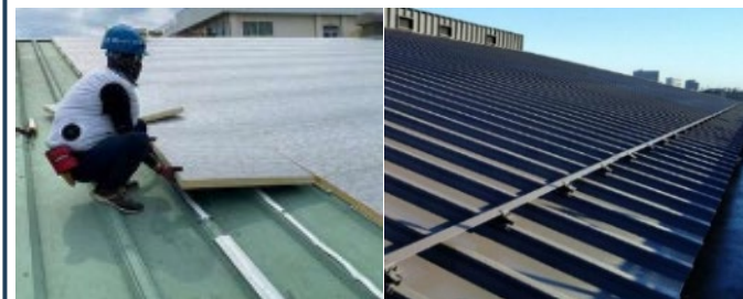
カバー工法による断熱
