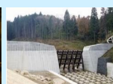
砂防関係施設整備
