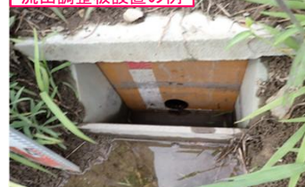
流出調整板設置の例
