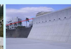
海岸保全施設整備
