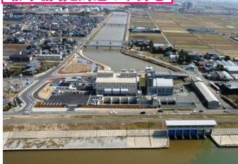
排水機場と周辺の市街地
