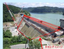
ダム建設・再生
