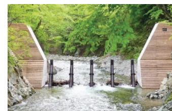
流木捕捉式治山ダムの 設置による流木対策
