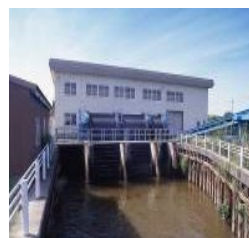
排水機場の整備
