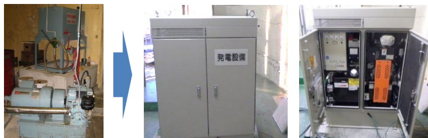
老朽化発電機の換装(72時間連続運転可能な発電機へ換装)
