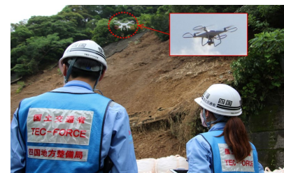
ドローンを用いた被災状況調査
