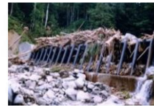
流木捕捉式治山ダムの設置
