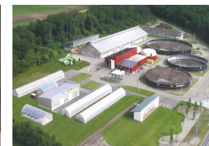
バイオガス発電・熱利用
