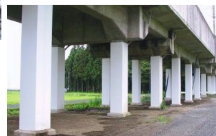
鋼板巻きによる高架橋の耐震補強
