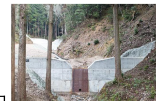
土砂流出を防止する 治山ダムの整備
