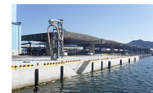
岸壁の耐震化
