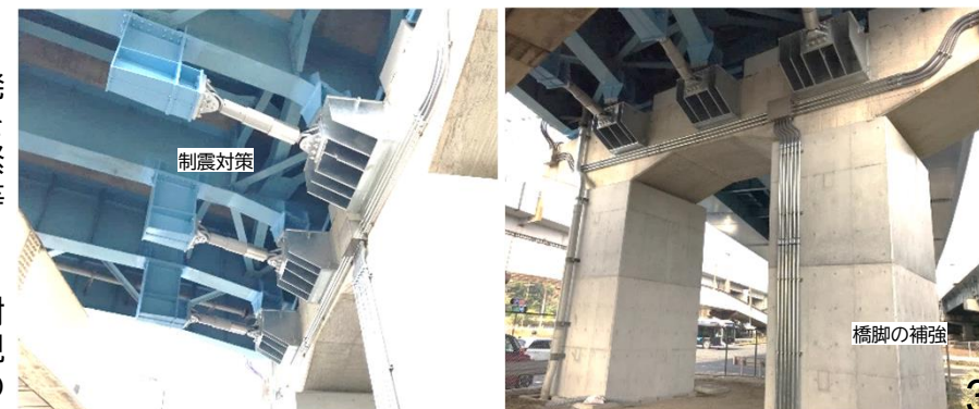
【国道357号 葛西高架橋における耐震補強実施状況】 (東京都江戸川区)
