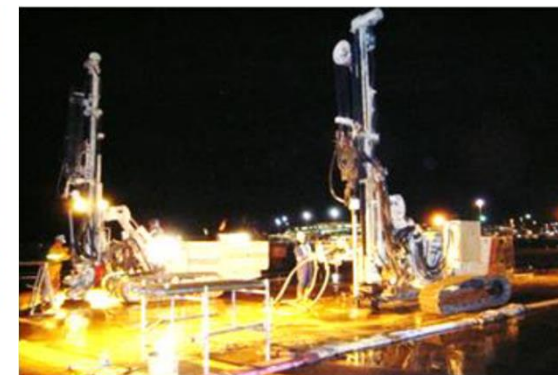
地盤改良施工状況
