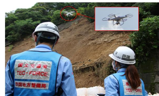
ドローンを用いた被災状況調査
