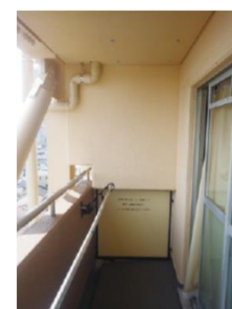
制震ブレースをバルコニーに設置
