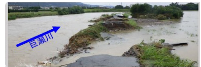
河川氾濫(R5.7豪雨)
