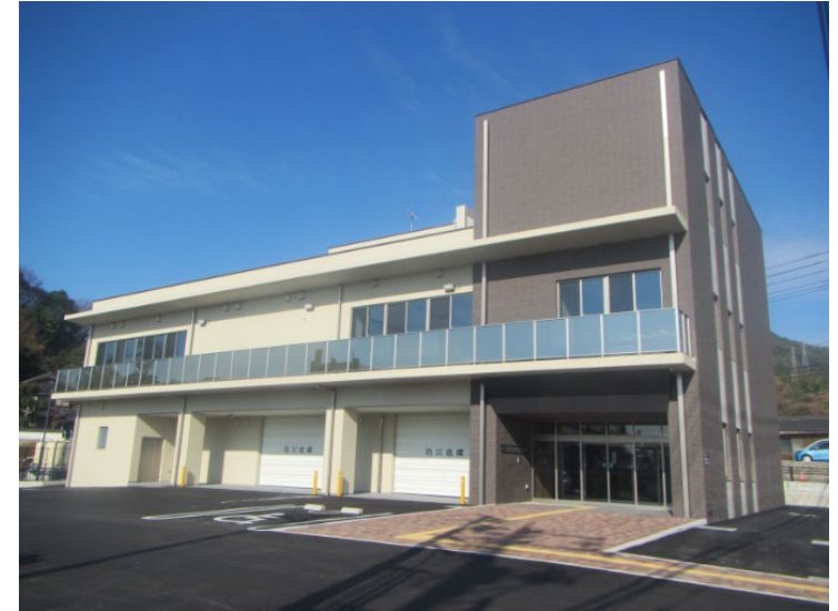
防災庁舎（防災指令拠点施設）
