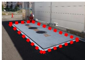
非常用自家発電設備用 埋設型燃料タンク①
