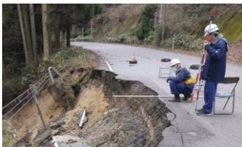
危険箇所での被災状況調査
