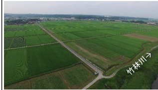
整備前(令和元年8月撮影)
