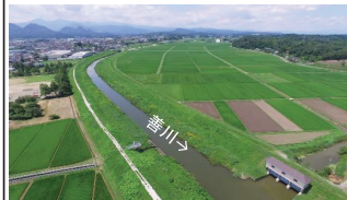
整備前(令和元年8月撮影)
