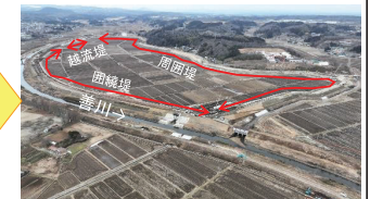
整備後(令和5年2月撮影)
