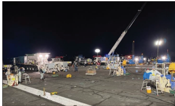
【滑走路の耐震対策 施工状況】
