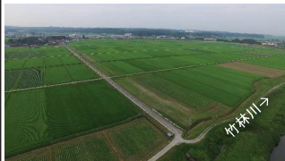
整備前(令和元年8月撮影)
