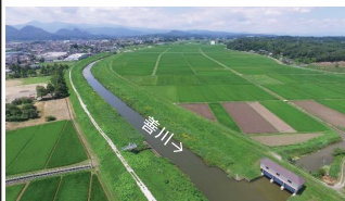
整備前(令和元年8月撮影)
