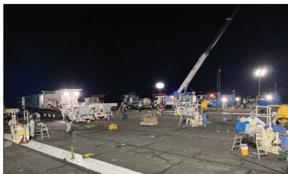
【滑走路の耐震対策 施工状況】
