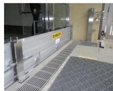
止水板の設置による防災機能強化イメージ
