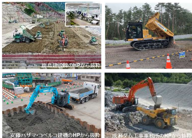
令和6年度の自動施工試行工事
