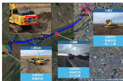
施工データの高度利用による 建設現場の見える化
