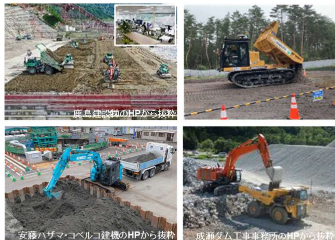
令和6年度の自動施工試行工事
