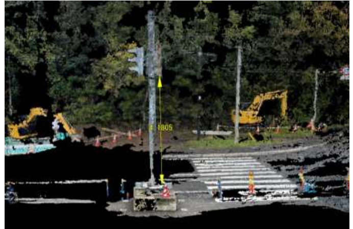
モバイル端末を用いることで、TLSやUAV等と比較して経済的であり、小規模工事では有効である。
