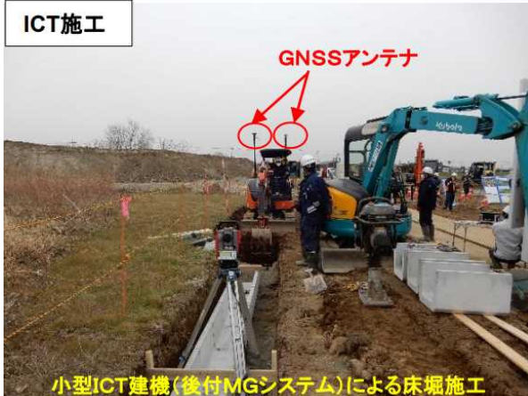
道路工事における排水構造物工の床堀作業において小型のマシガイダンスシステムを活用
