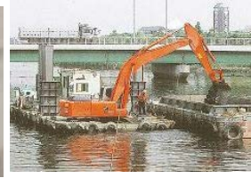
河川維持工事(浚渫)
