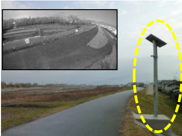
簡易型河川監視カメラ
