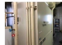
空調機更新（放送研究棟）
