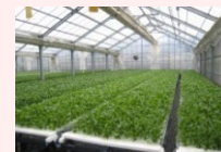
農業生産施設（水耕栽培ハウス）
