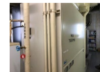
空調機更新（放送研究棟）
