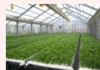
農業生産施設（水耕栽培ハウス）
