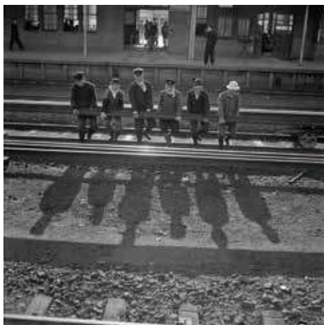
駅構内でレールを運ぶ6人組 日田駅 昭和32(1957)年
