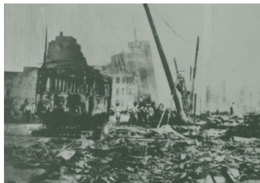
福井震災後の駅前電車通り
