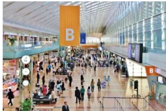
羽田空港ターミナルビル
