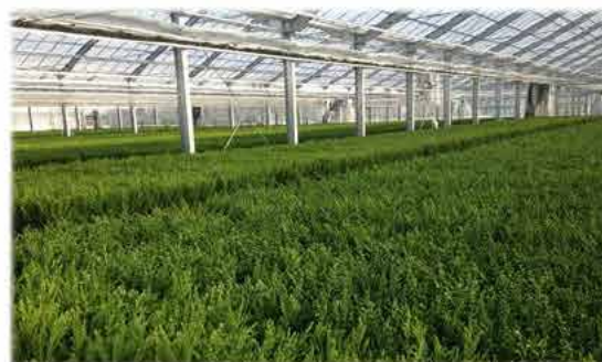
スギコンテナ苗木生産施設（宮崎県日向市）
