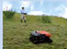
無線草刈機の運用に対応した傾斜
