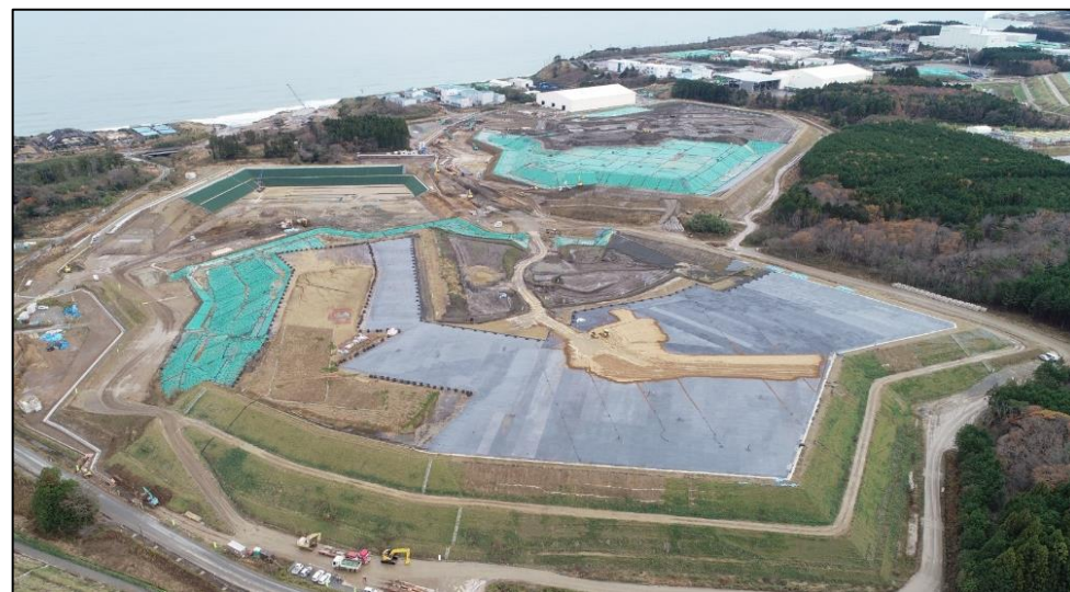
中間貯蔵施設における除去土壌の保管の様子
