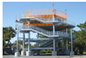
避難タワーの整備
