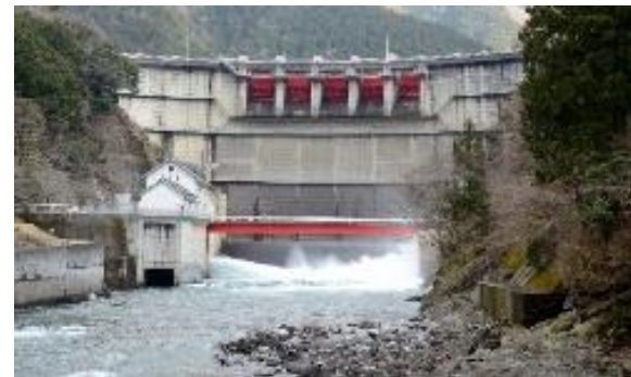
農業用ダムの堆砂対策による貯水容量の確保や洪水調節機能の強化に資する施設整備
