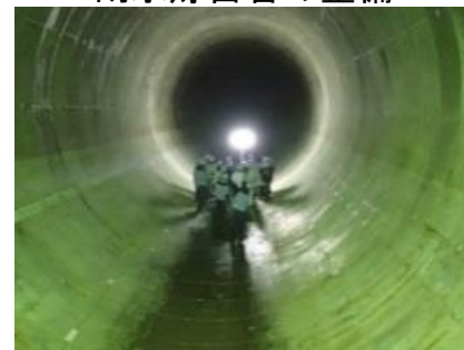
雨水貯留管の整備
