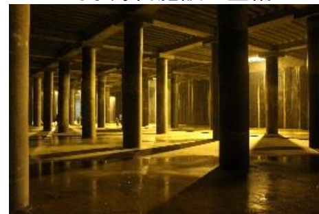
雨水貯留施設の整備
