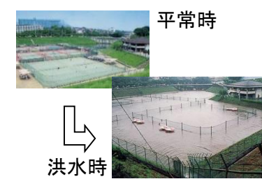
貯留施設の整備
