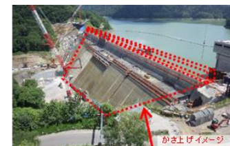
ダム建設・ダム再生
